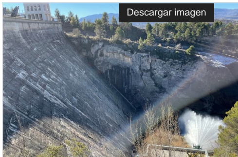
Presa de Talam
